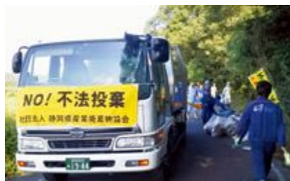
▲不法投棄物撤去作業
